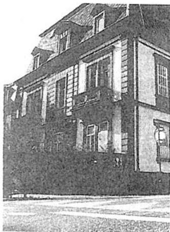
L'association Villa 17 bataillait contre un immeuble contemporain devant être construit à l'arrière de cette villa au 17, rue Goethe. PHOTO ARCHIVES DNA - MICHEL FRISON
